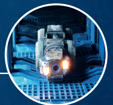
Inspeksjonskamera i tanken
